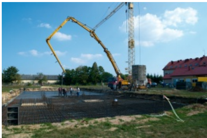
Trwają prace przy wylewaniu płyty fundamentowej pod budynek nowego przedszkola w Strawczynie.
